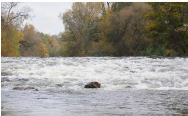
Abb. 5.19.: Die Sohlrampen in der vereinigten Argen sind zwar einzeln gut überwindbar, aber auch Seeforellen haben einen hohen Energieaufwand bei der Überwindung aller 20 Rampen.
