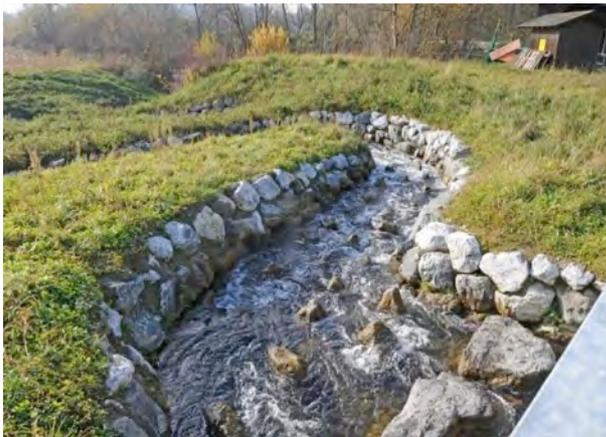
Abb. 5.21: Das technische Umgehungsgerinne in Föhlschmitt ist zumindest für Seeforellen kaum überwindbar.
