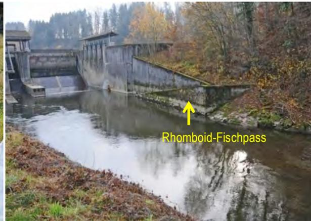
Abb. 5.22: Das Wehr beim Sägewerk Hiltensweiler bildet ein unüberwindliches Hindernis. Der alte, steile Rhomboid-Fischpass ist nicht mehr funktionsfähig.
