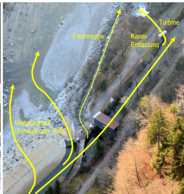
Abb. 7.52: Am Kennelbacher Wehr gibt es mehrere Abstiegswege für Smolts. Bei Niederwasser endet einer davon in den Turbinen der beiden Kraftwerke.
