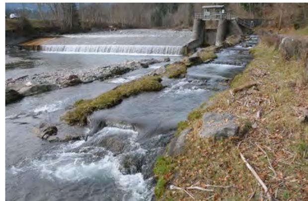
Abb. 7.26: Der Beckenpass am Wehr Egg (F-km 25,3) ist – vorausgesetzt, dass er nicht von Totholz verklaust ist und aufgefunden wird - auch für große Forellen passierbar.
