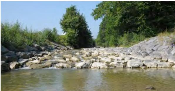
Abb. 8.22: Niederwasser im Unterlauf der Goldach macht auch mit Rampen sanierte Schwellen wieder zum Hindernis (F-km 0,6).
