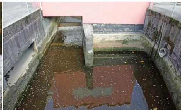
Abb. 5.20: Aufstiegsgrenze Kleinkraftwerk im Argen-Kanal (abgelassen). Hier existiert keine Fischwanderhilfe.
