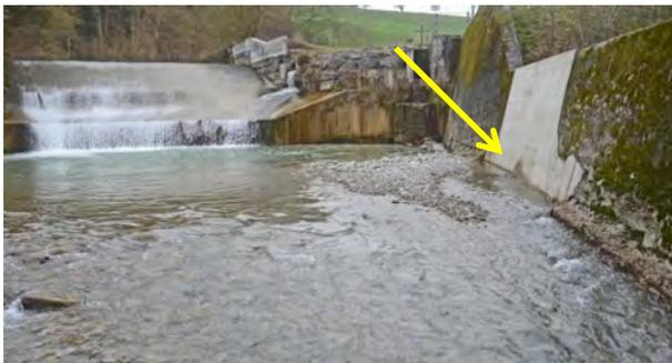
Abb. 8.28: Der Einstieg zur Fischwanderhilfe am Wehr Mühlbrugg (F-km 2,75) ist schwer aufzufinden und nach Hochwasser manchmal mit Kies verschüttet .
